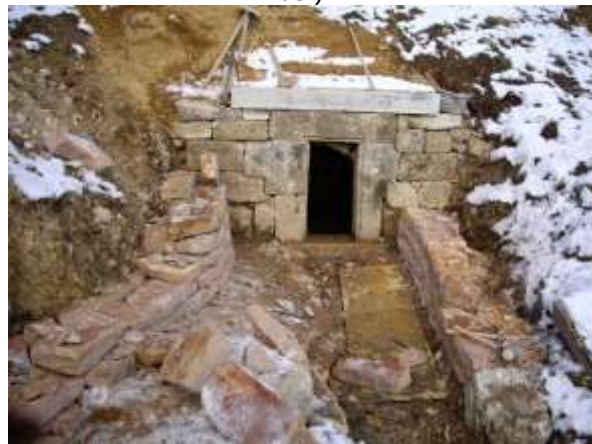
Trockenmauerbau auf Seiten
