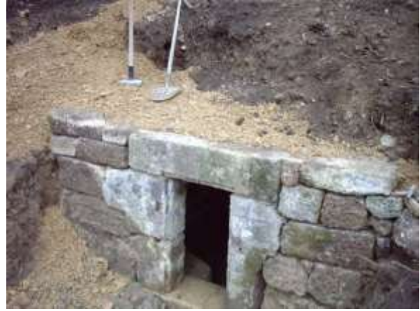
Vormauerung wieder hergerichtet
