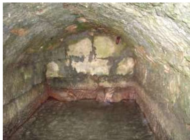
Hinten über Wasserspiegel links und rechts 2 Akten (Zu- läufe) sichtbar
